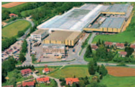
Usine d'Ochsenhausen (Allemagne) 200 000 m 2 de terrains.
